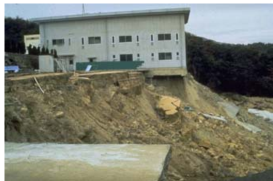
شکل پ-۲-۶- انتخاب ساختمانی مناسب و اجرای غلط ساختمان بر روی سطح شیب دار
