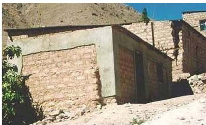
شکل پ-۲-۲۱- ساختمان جلو به دلیل داشتن کلاف آسیب ندیده ولی ساختمان بدون کلاف آسیب دیده است.
