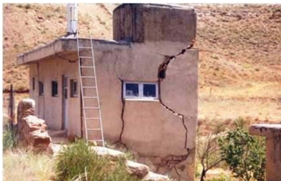
شکل پ-۲-۶- انتخاب ساختمانی مناسب و اجرای غلط ساختمان بر روی سطح شیب دار
