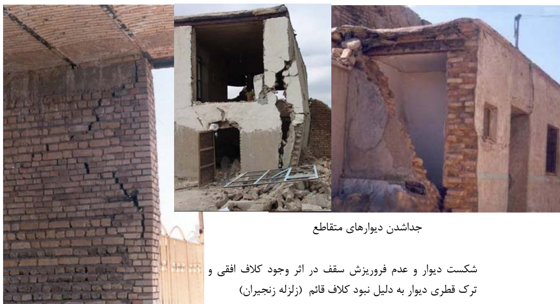
شکل پ-۲-۸- شکست اتصال دیوار-دیوار و دیوار-سقف در ساختمانهای بنایی
