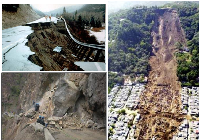
پ-۲-۴-۶- مدفون شدن ساختمانها و تخریب راه اصلی بر اثر زمین لغزش
